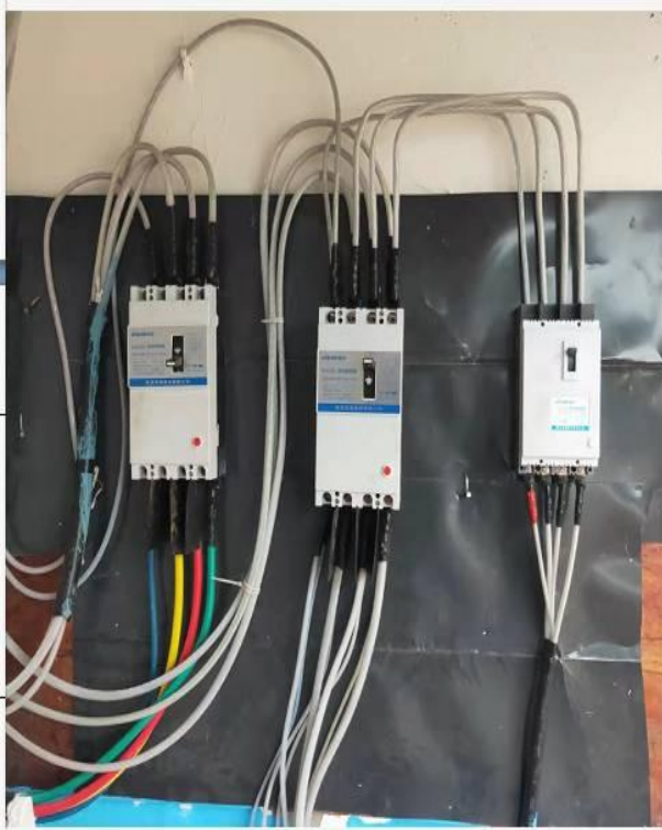
配电板已涂防火漆
