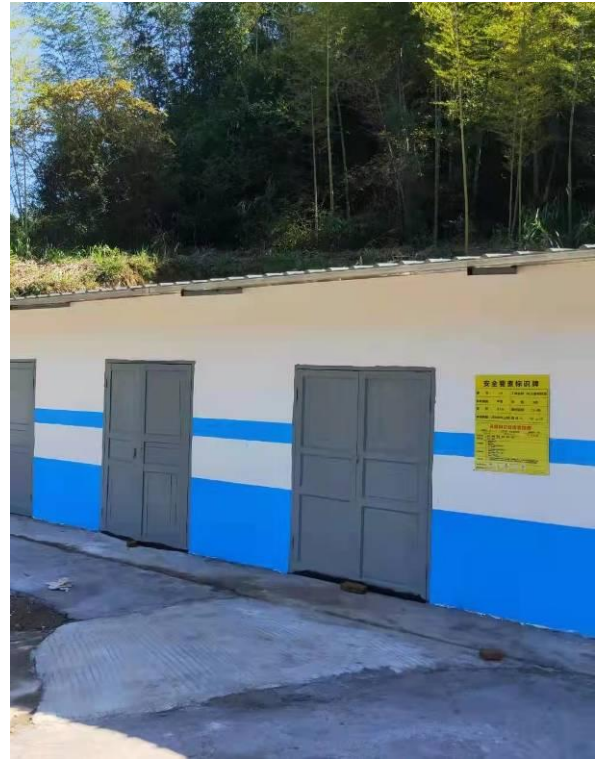
化工库的门已涂防火漆
