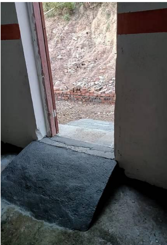
48 号封口后中转库后门台阶已改设斜坡，已张贴操作规程，已挂温湿度计及记录本已划限高线
