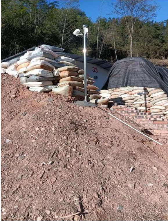
33 号拌砂中转门口侧防护屏障已加宽、加高
