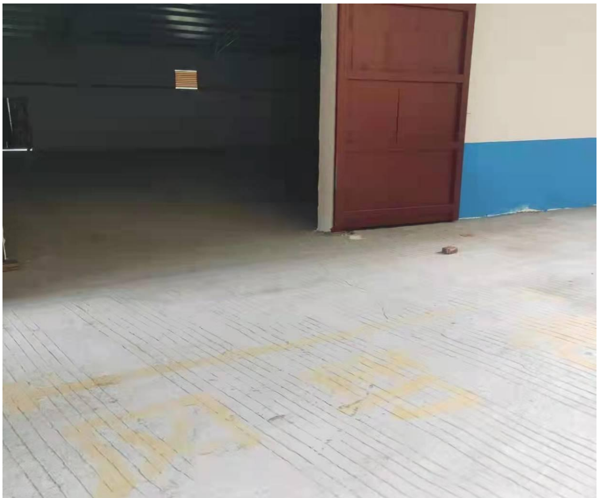
成品库已设限高限、装卸线，已挂管理制度
