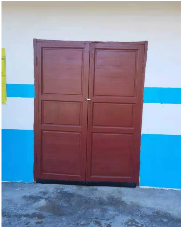
成品库、引线库等底部门缝已封堵
