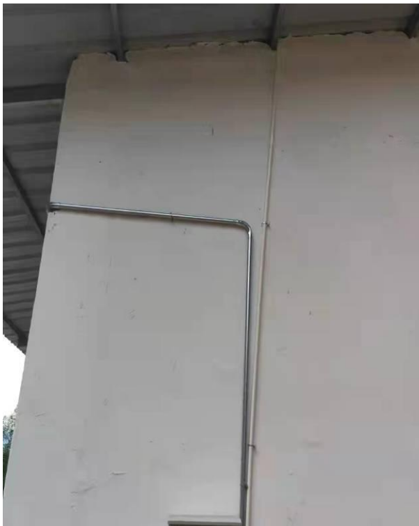
金属屋面已接地
