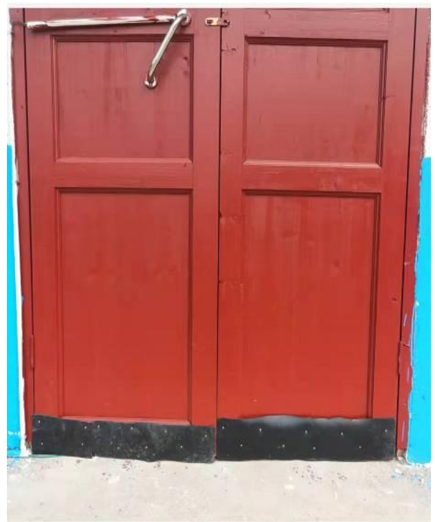
成品库、引线库等底部门缝已封堵
