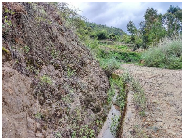
2-6 库西侧截洪沟
