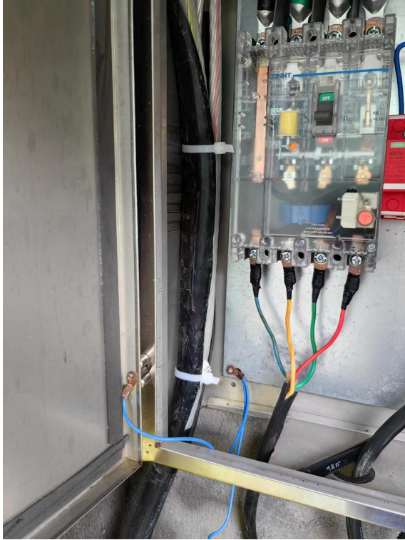
配电箱门已跨接接地
