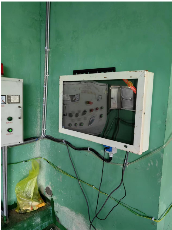
工房插座可断电插拔，供插座回路已采用漏电型断路器；显示屏已增设防护措施
