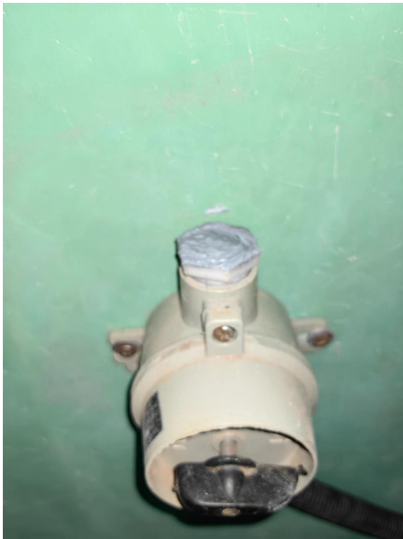
开关末端口已封堵
