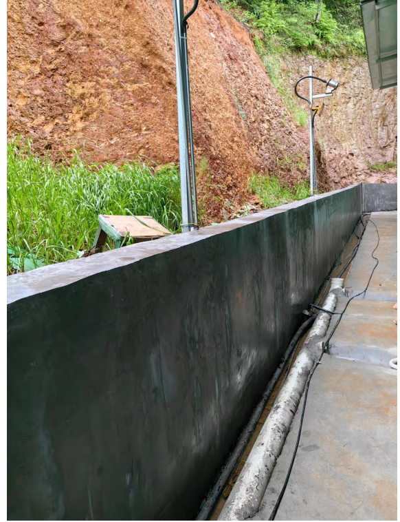
装药间后面的砖墙已粉刷、抹光
