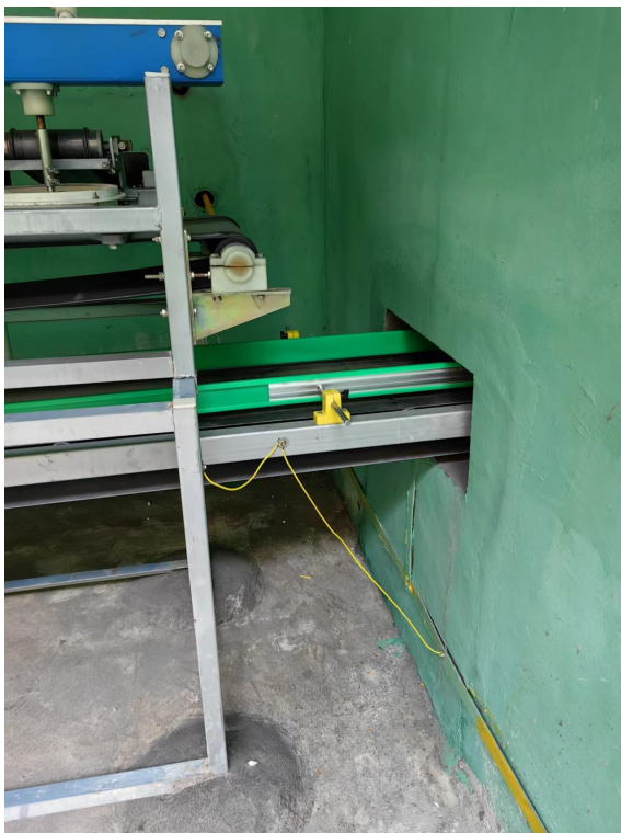
传动电动机机架接地线已改为并联，传动机架之间接地线已连接
