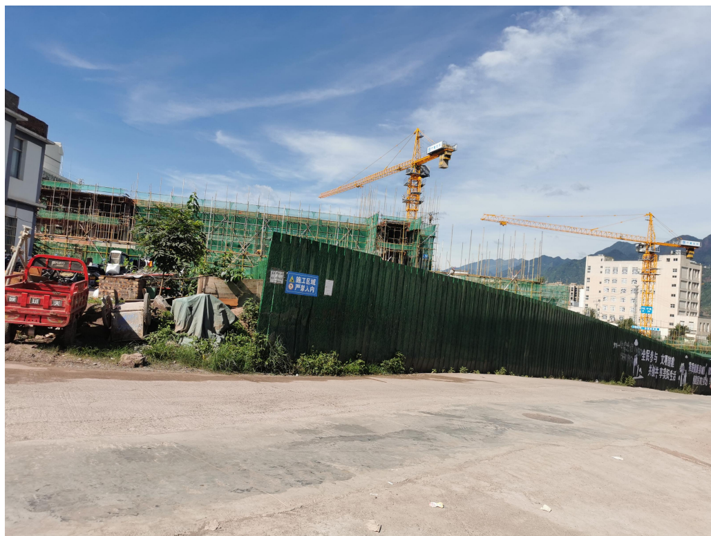
南面：正在建设的学校（新城中学）
