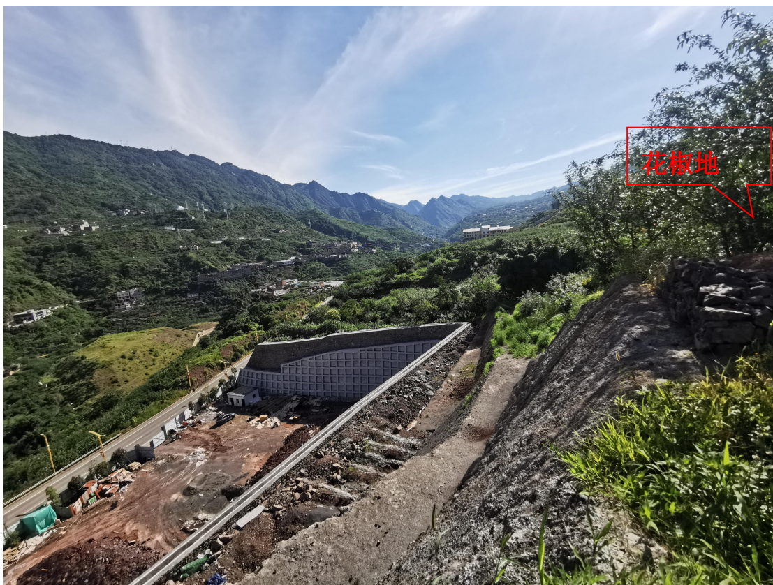
南面：边坡（花椒地）
